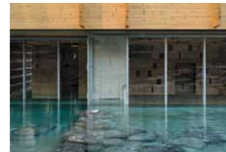
Den raumhoch verglasten Beobachtungsräumen ist ein Biotop vorgelegt. Durch die hohe Transparenz können nicht nur die Zuschauer, sondern auch die Bären ihre Neugierde befriedigen.
