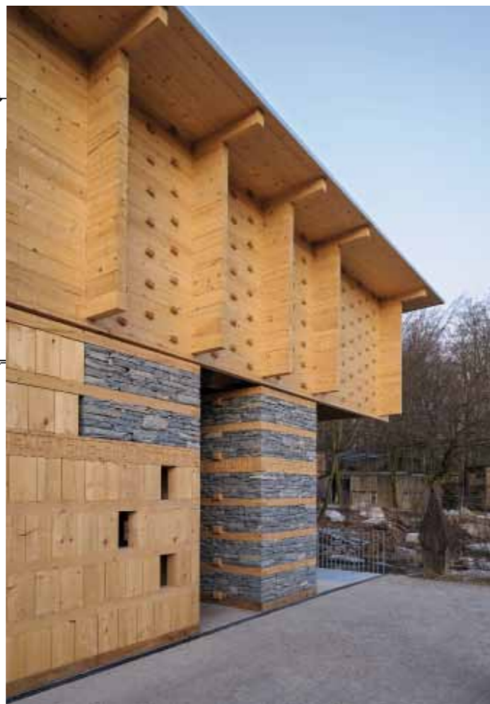
Auf Trockensteinmauern und nicht verleimten Weisstannenbalken ruht ein mächtiges Holzdach in Strickbau.
