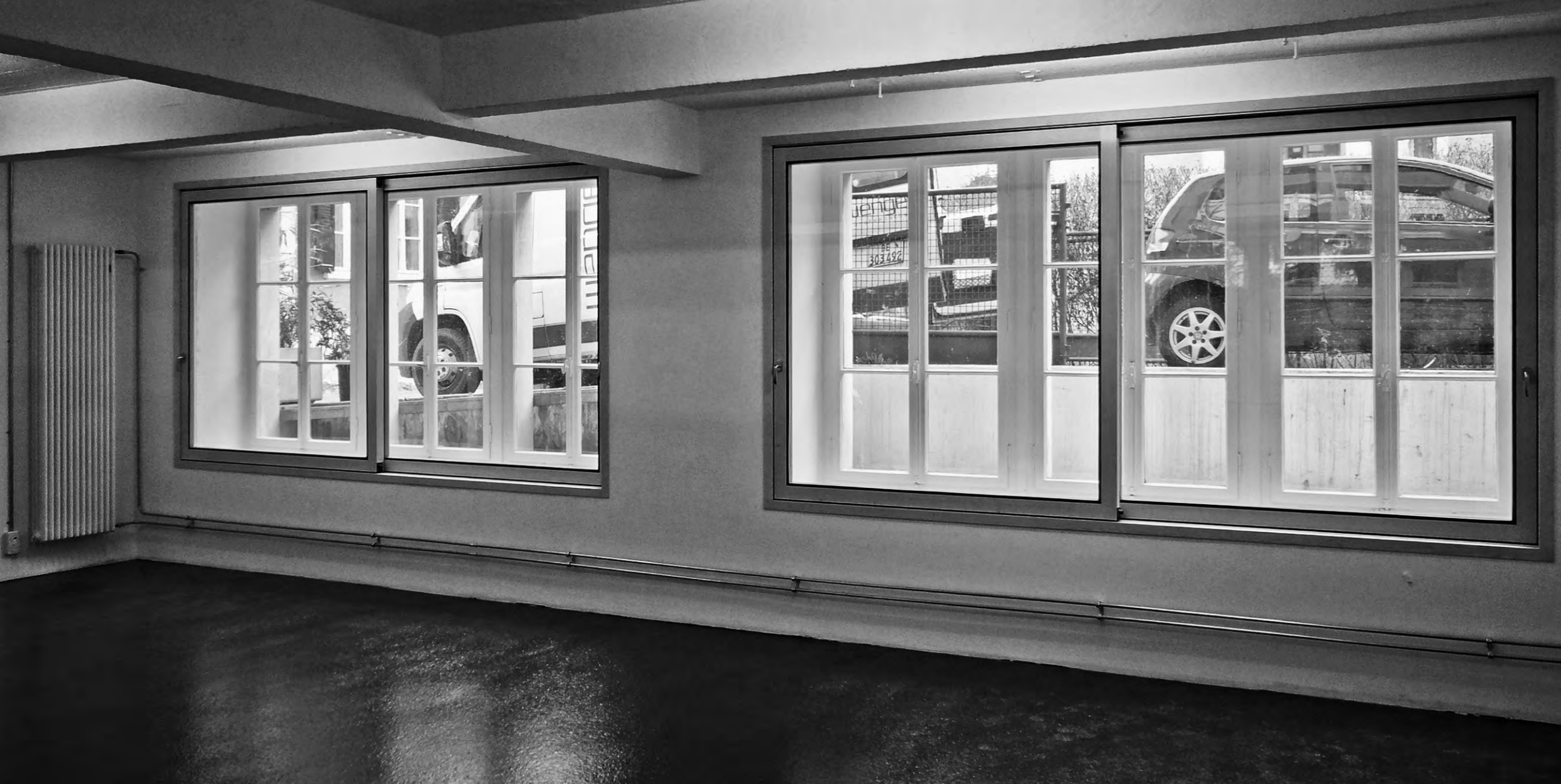
Biel: Neue, dreifachverglaste Schiebefenster ermöglichen den Erhalt der originalen, einfachverglasten Fenster.
